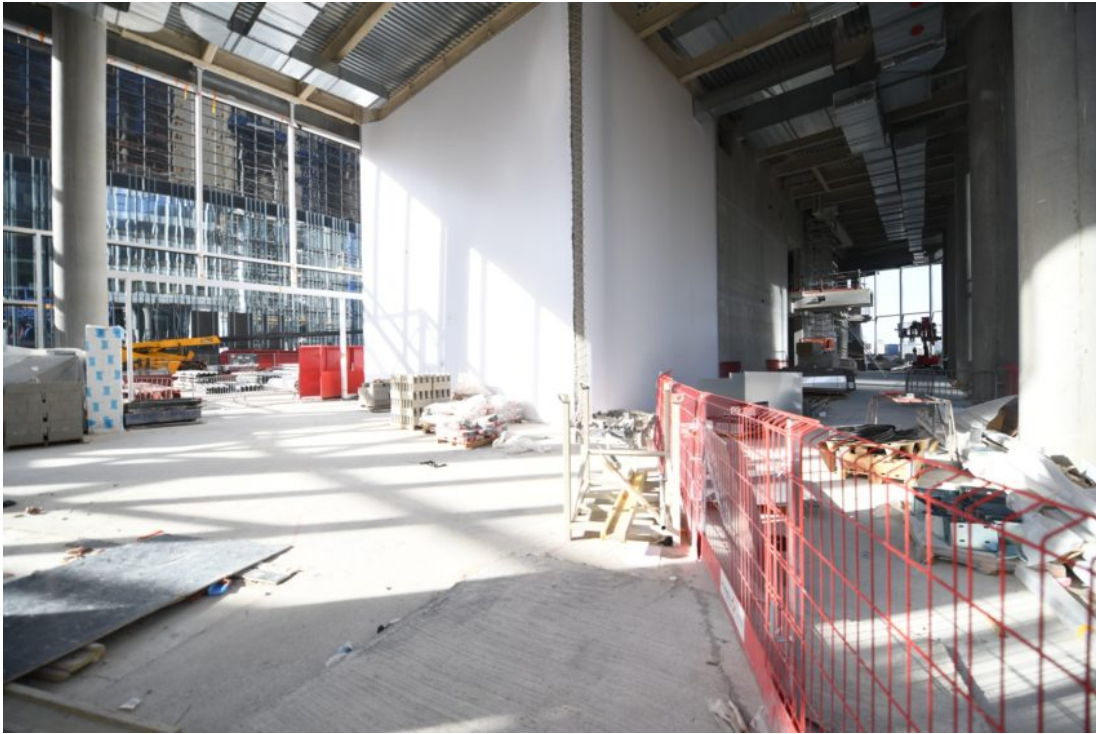
Ici sera le futur hall d'accueil de la tour Trinity – Defense-92.fr
