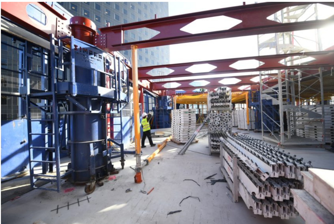
Les étages de la tour mêlent structure en acier et béton – Defense-92.fr
