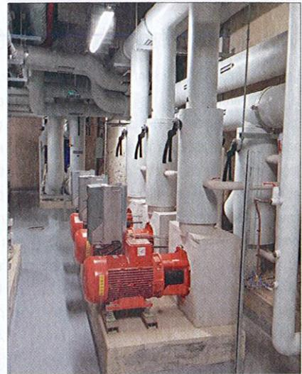
Locaux techniques en sous-sol avec échangeurs pour le circuit d'eau glacée et pompes de distribution.
