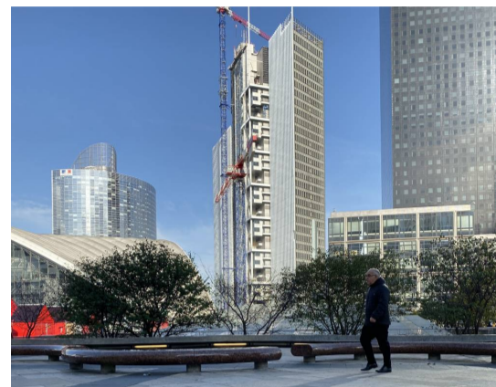
La tour Trinity en chantier, à La Défense © Cro&Co Architecture
